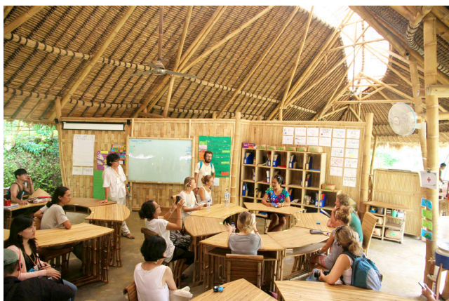
Несколько зданий эко-школы в Индонезии на острове Бали сконструированы полностью из бамбука; школу посещают дети от младших до старших классов
