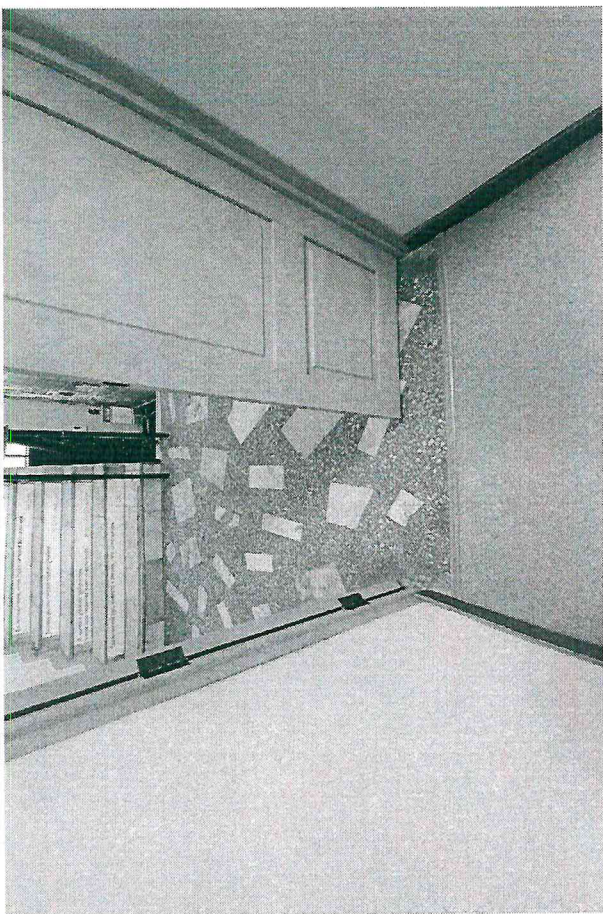
Фото 3/12 Дверь входа на лестничную клетку.
