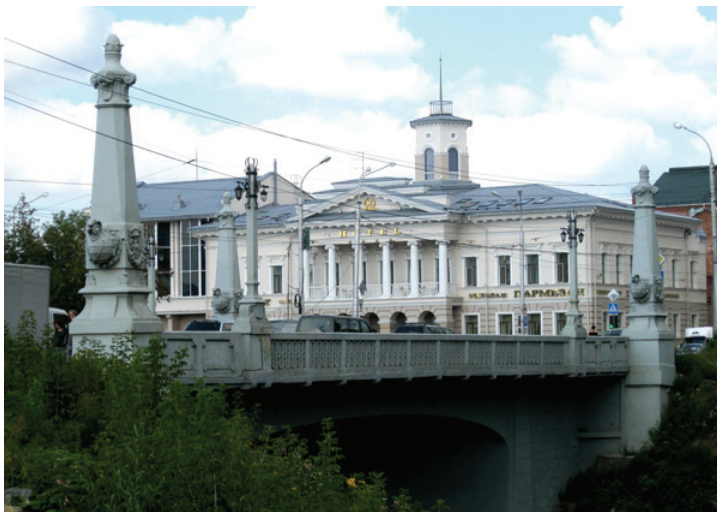
Рис. 15. Каменный мост через р. Ушайку
