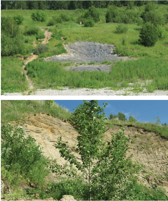
Рис. 3. Оползни на склоне под Лагерным садом
